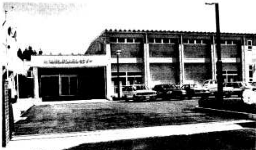
完成した農村環境改善センター
