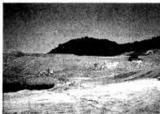
造成工事が進む工場建設予定地
