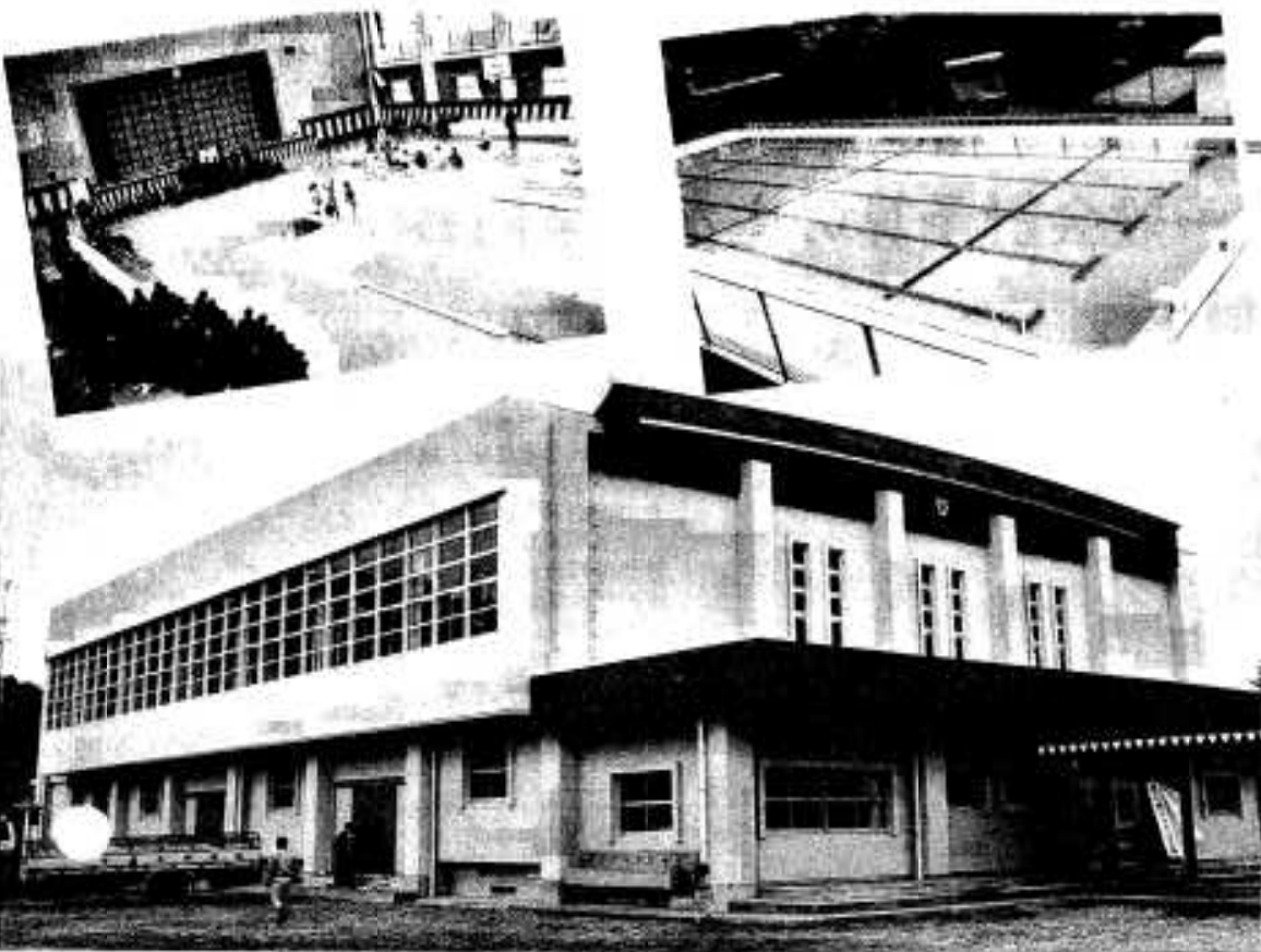
完成した体育館とプール (右上)
