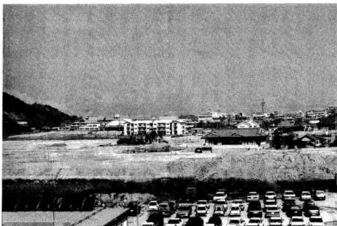
整備が進む湯地区土地区画整理
