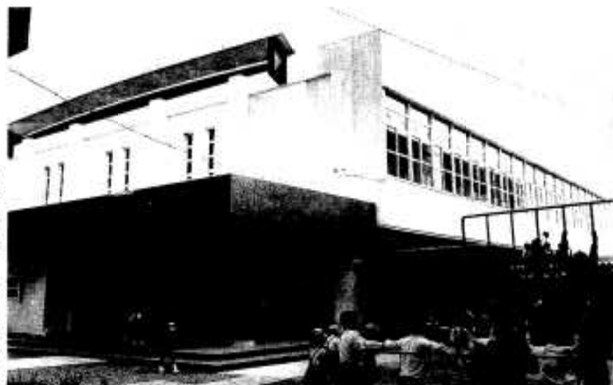
阿久根小学校の体育館完成（2月）
