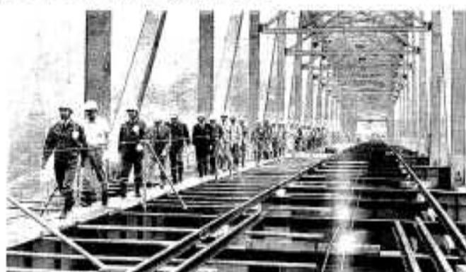
阿久根と長島の両側から工事が進められ ついに結ばれた橋を歩き喜んだ関係者ら
