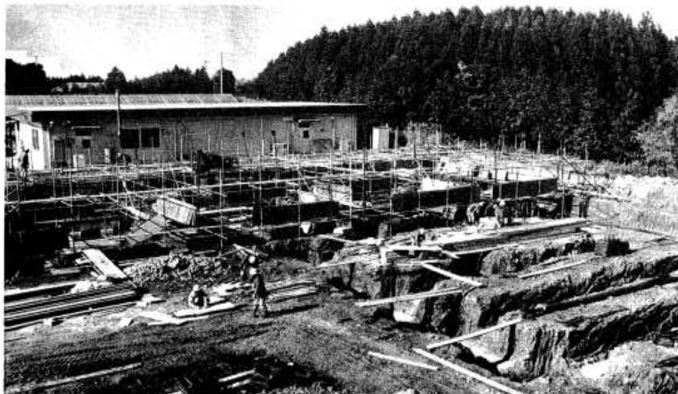
急ピッチで工事が進む農村環境改善センター（左上建物は農林業振興センター）
