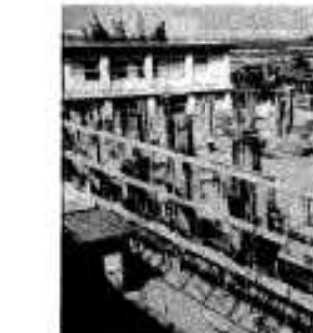
順調に工事が進む阿久根小学校体育館
