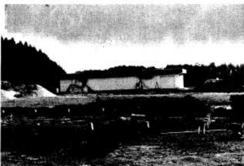
建設が進む農林業振興センター（写真の建物が完成した種菌研究棟）
