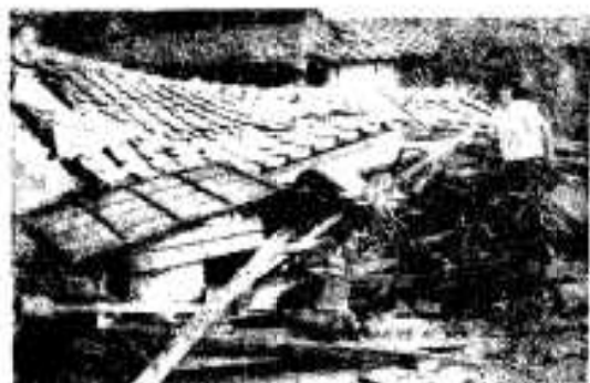
全壊住宅（西目）
