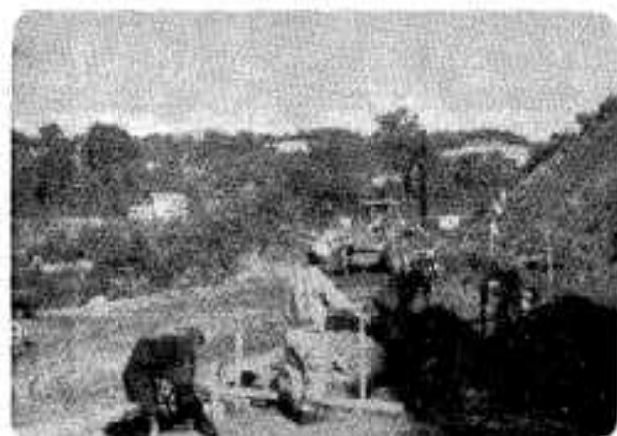
(赤瀬川付近の国道整備工事)
