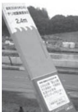
チリ地震津波の水位を示していた壊れた看板
