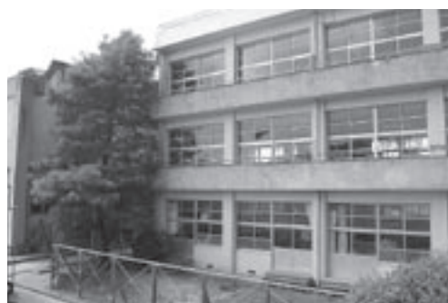
耐震工事が予定されている校舎 （阿久根中学校）
