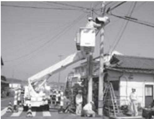
高所作業車を使っでの信号機清掃
