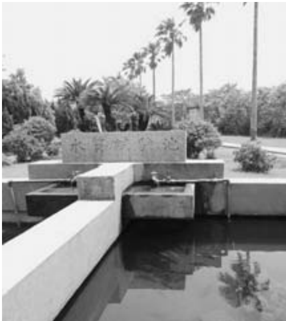
水源地から取水した水に有害な微生物などが混入していないかコイなどで検査する水質試験池 (宮ノ前水源地 波留区)
