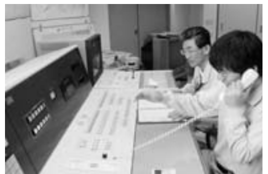
関係機関と連携し、訓練を行った高松ダム管理演習 (5月11日)
