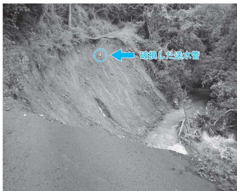
道路崩壊（市道本之牟礼線）により、送水管が破損し牛之浜区で断水
