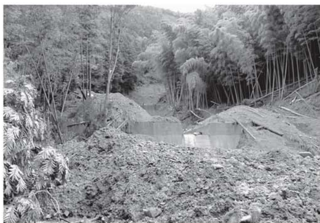
土石流の被害を最小限に食い止めた砂防ダム(弓木野区 横ヶ倉)
