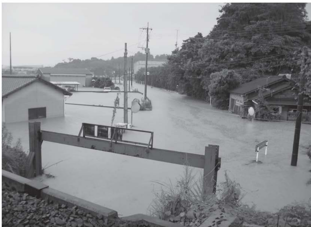
河川はらんによる冠水（折口駅近くガード上から国道3号望む）
