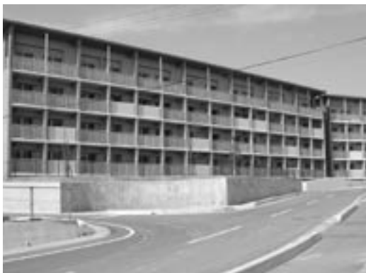
この4月から供用開始された寺山団地
