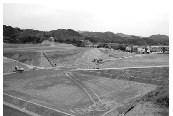
着々と整備が進む阿久根南部地区の土地基盤整備事業
