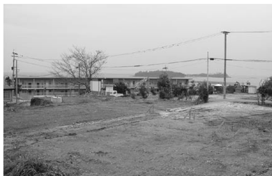
解体工事を終え、これから新築工事に取りかかる寺山住宅第2期工事の現場。奥に見えるのは、第1期工事で完成した県営住宅。
