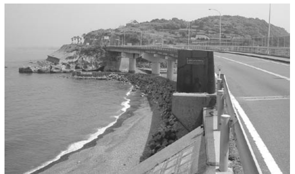
国道3号大川バイパス工事
