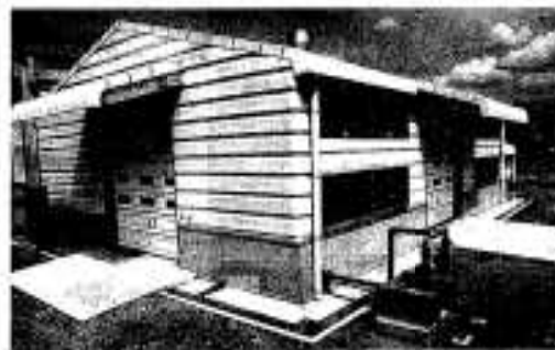
完成した活魚槽施設の外觀
