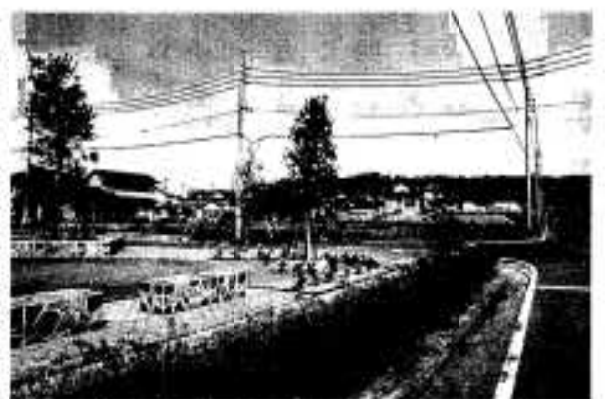
着々と整備が進む潟土地区画整理事業
