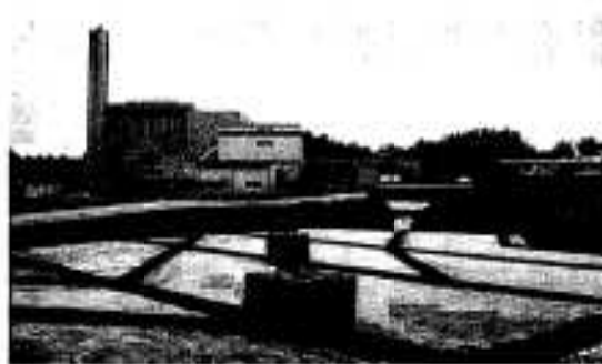
4月から供用開始される最終処分場
