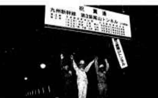
貫通したばかりのトンネルを通る工事関係者
