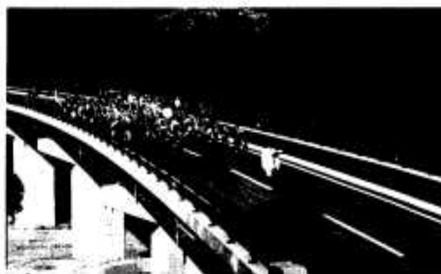
1月に開通した「鷹首橋」と「田代大橋」
