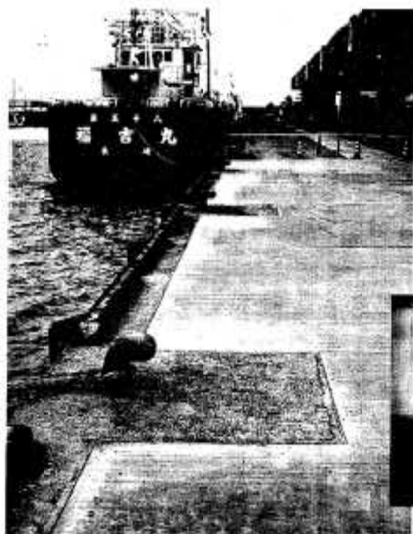
工事が終り東海船が接岸する新港
