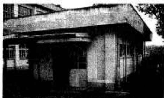
水洗化される臨本小学校便所
