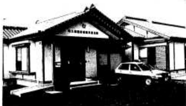
新築された脇本駐在所
