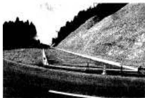
拡幅改良工事も順次進められている
