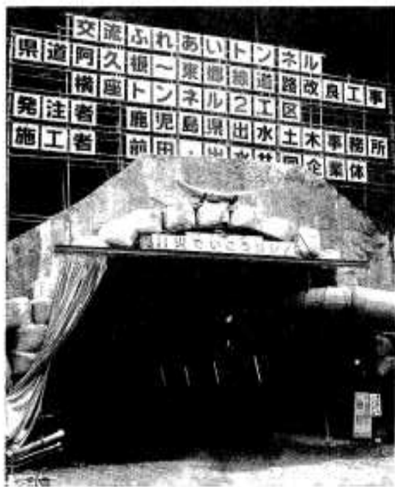
着々と工事が進む横座トンネル
