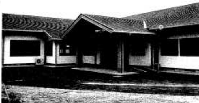
広域農道西目入口に完成した構造改善センター
