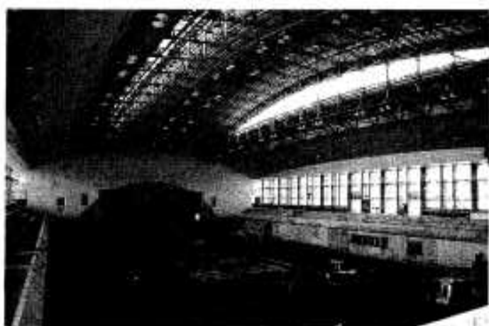
6月末完成へ向け着々と工事が進む総合体育館
