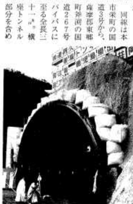
本格工事が始まった横座トンネル（米次区）
