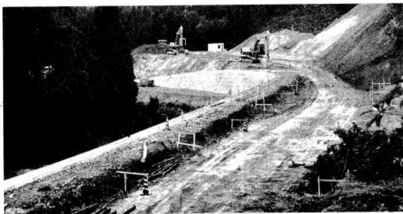
各所で大がかりな工事が行われている県道阿久根東郷線。写真は米次区。
