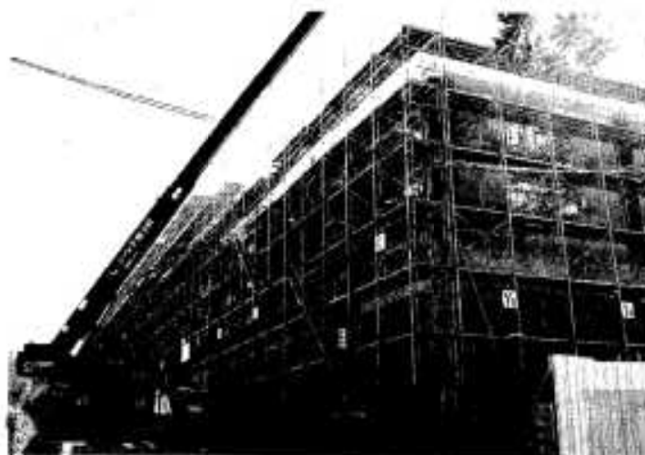
著々と建設が進む総合体育館
