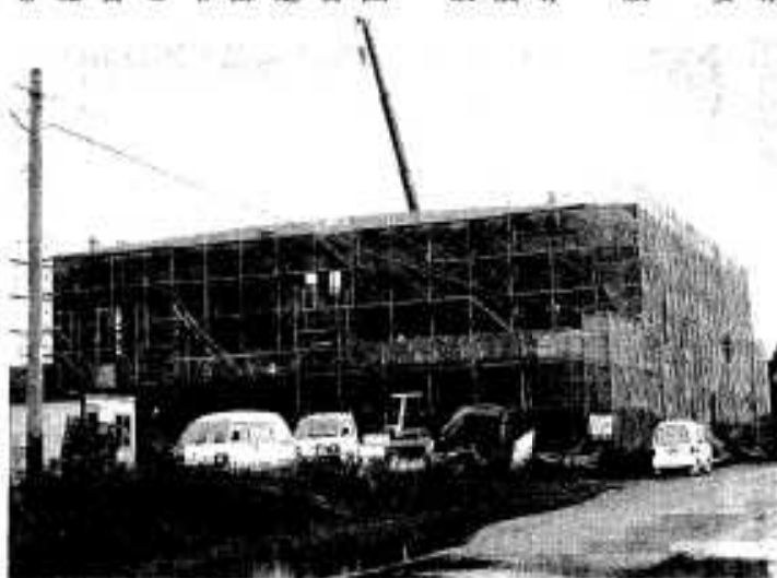
9月完成を目指し、着々と工事が進む折多小体育館
