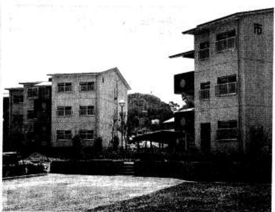
濁区柿山団地横に新たに建設されたふれあい団地
