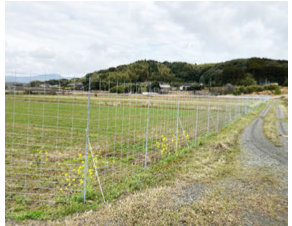
事業で整備された防護柵（内田区）
