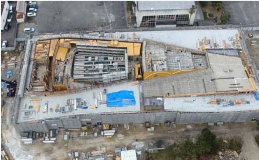
上空からの建設現場の様子(1月撮影)。右上は市民会館。
