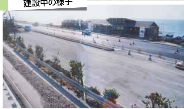
建設中の様子
