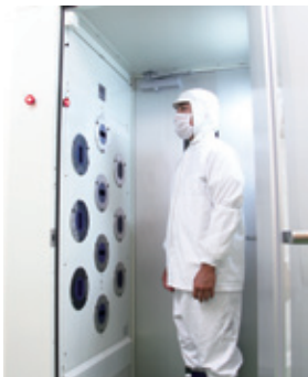
加工棟へは、必ずエアシャワーを使用してから入室します。
