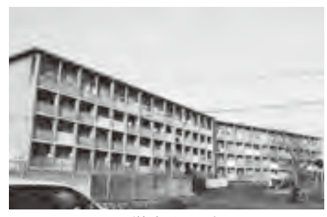
県営寺山団地
