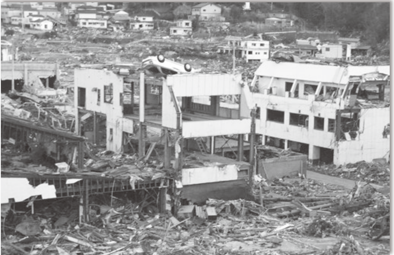
津波の高さを物語る建物屋上の車（宮城県牡鹿郡女川町）
