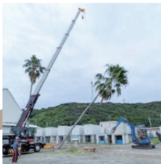
クレーンで吊るしながら幹を 切断し、安全なスペースに倒 します。
