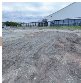
木の根の除去後、土で埋め戻 し、整地を行って伐採作業が 完了しました。
