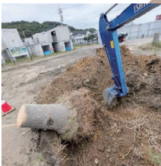
再発芽しないように、木の根 を完全に除去する「伐根」作 業を行います。
