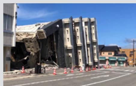
◀輪島市中心部で倒壊したビル
