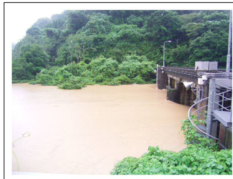
ダムの越流状況 北薩豪雨 平成18年7月22日(日雨量 509mm)
