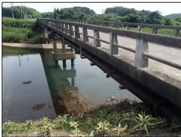
図 3-36 阿久根市大曲橋の橋梁添架管(鑄鉄管)
