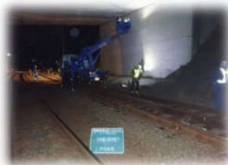
↑ 線閉閉鎖工事夜間作業。 軌陸車を使用。
