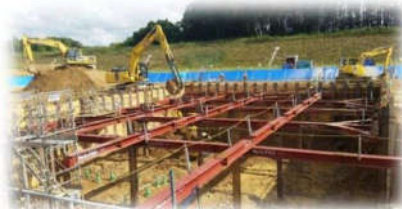
↓ ゴミ処理施設建設工事
