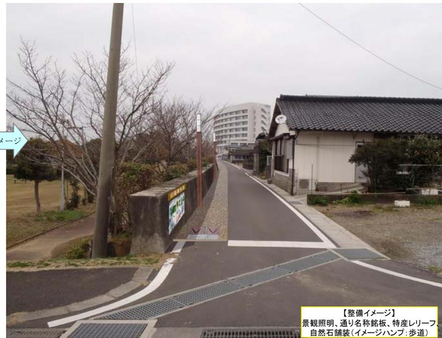
■道路護岸側に自然石舗装などを用いた旧護岸と調和した景観舗装により、安全性と景観性を高めたイメージランプ（歩道部）を確保する。
