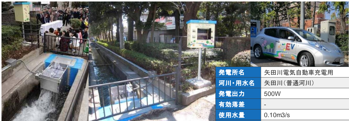
図 5-18 縦軸クロスフロー水車の概要 (BESTAQUA MFV200 型：三菱電機プラントエンジニアリング(株))
