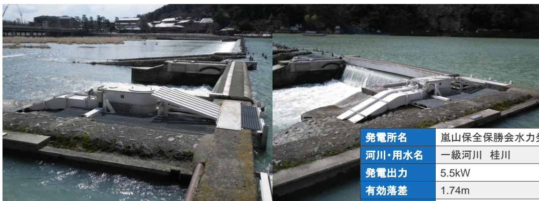
図 5-16 サイフォン式プロペラ水車の概要（サイフォン TM5 型：チェコスロバキア マーベル社）
