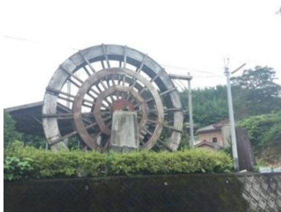
【尾崎地区（尾崎公民館水車）】
