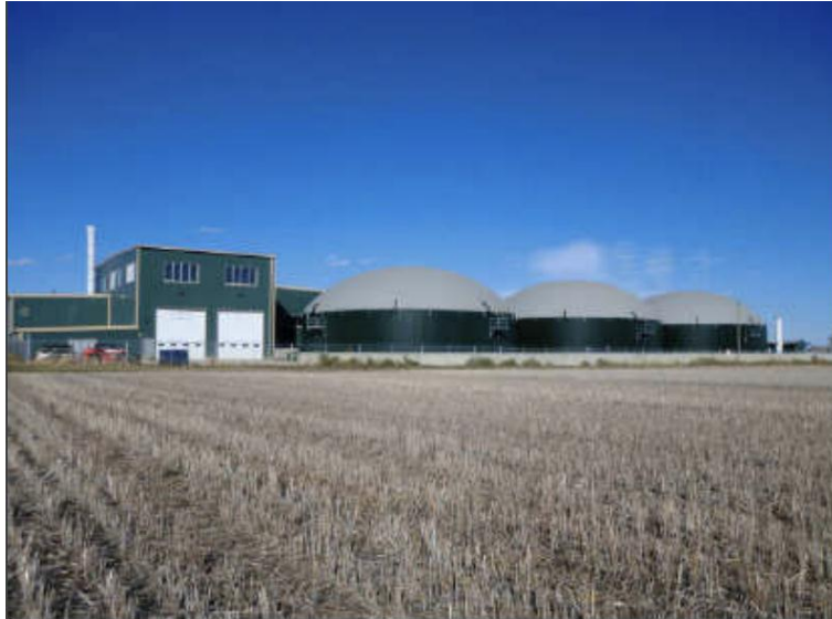
図 3-15 Leathbridge Biogas LP の全景
