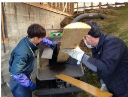
背板を破碎チップパーに投入する様子。
