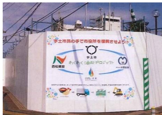
宇土市役所解体工事現場の看板
