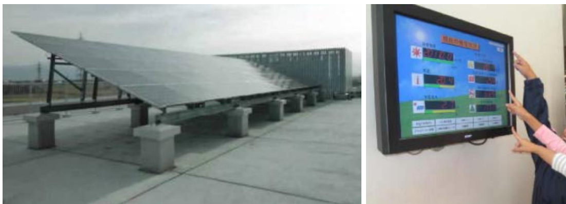
小学校の屋根置き太陽光パネルと発電状況画面
