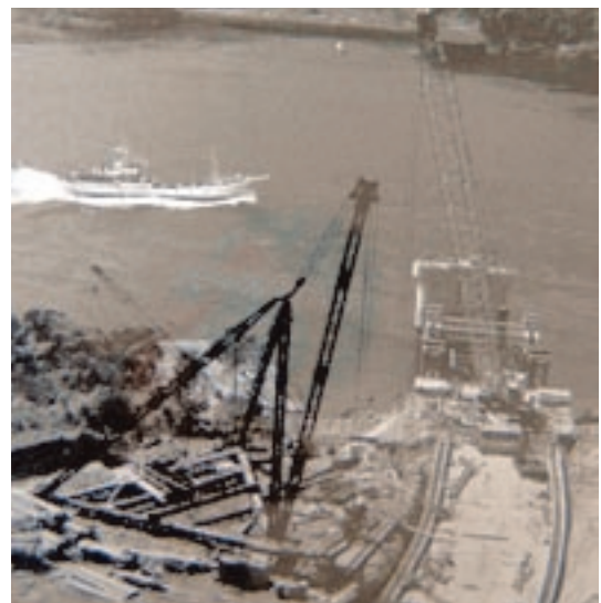
昭和46年 黒之瀬戸大橋工事
