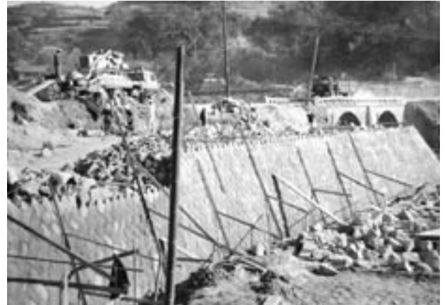
昭和38年 大川橋工事
